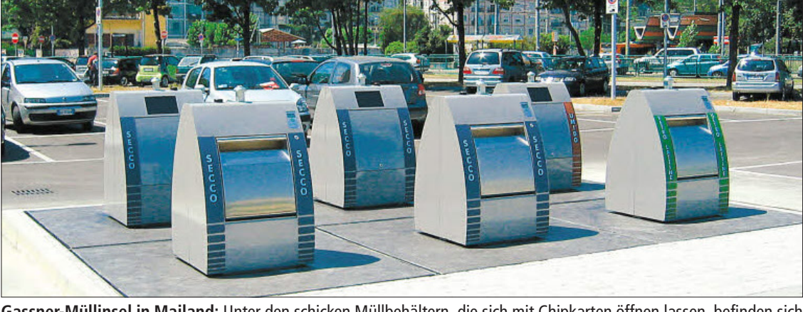
Gassner-Müllinsel in Mailand: Unter den schicken Müllbehältern, die sich mit Chipkarten öffnen lassen, befinden sich riesige Container. Per SMS kommt die Nachricht, wann diese voll sind. Erst dann wird entleert. Bild: SN/GASSNER
